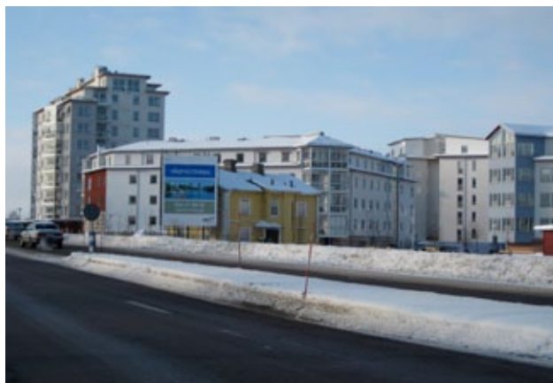
Vågmästarbostaden från 1800-talets första hälft är skyddad mot rivning och förvanskning i detaljplanen. Foto: Föreningen Karlstad Lever 2009.
